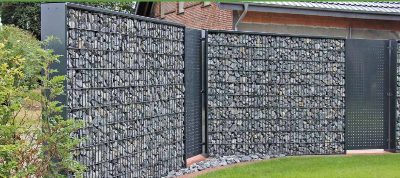
Gabionen in Kombination mit Lochblech-Elementen, anthrazit pulverbeschichtet
