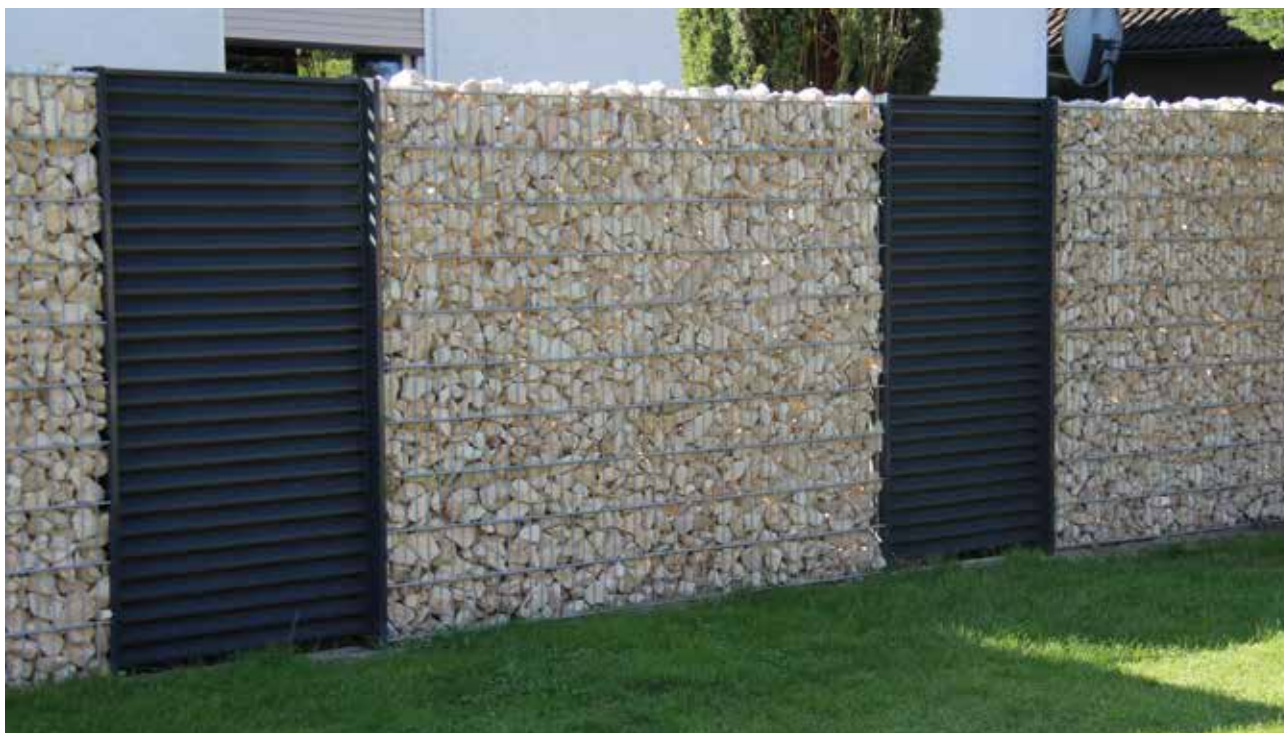
Gabionen in Kombination mit Sichtschutz-Element Malaga, Seitenbleche anthrazit pulverbeschichtet, Gittermatte verzinkt
